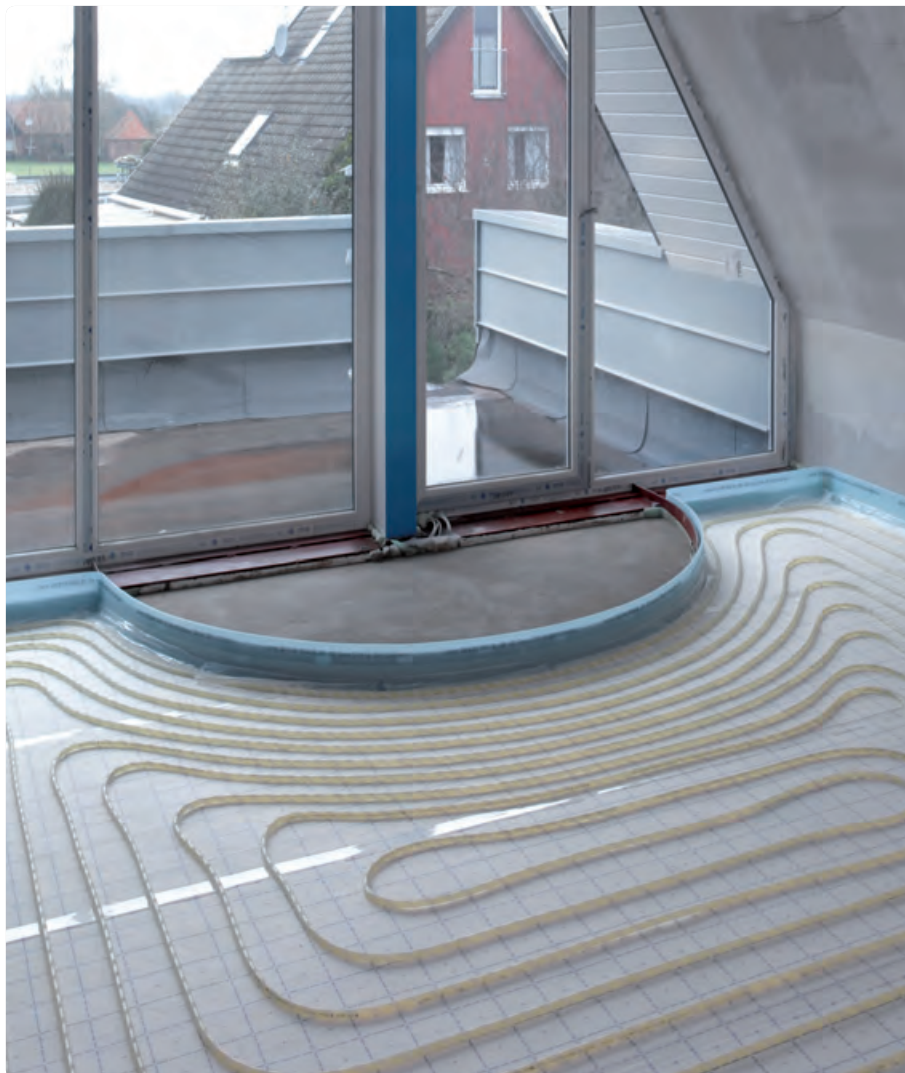
Zo kan de vloerverwarming spelenderwijs worden geïnstalleerd – met het Uponor klittenbandsysteem
