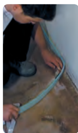
Uponor Minitec randisolatiestrook monteren
