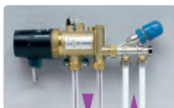
Aansluiting van de vloerverwarming
