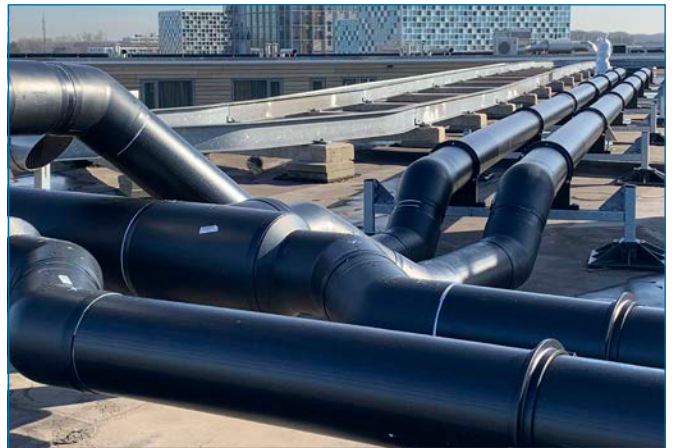
COOL-FIT 4.0 hoofdleidingen met aftakkingen
