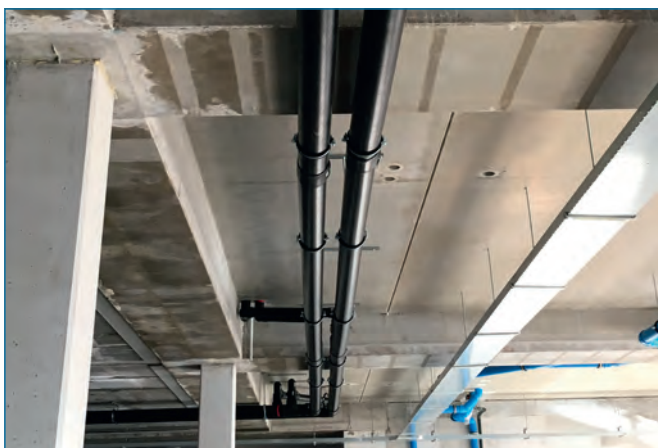
COOL-FIT 2.0 in klimaatinstallatie voor winkels en schachten in Zwaag
