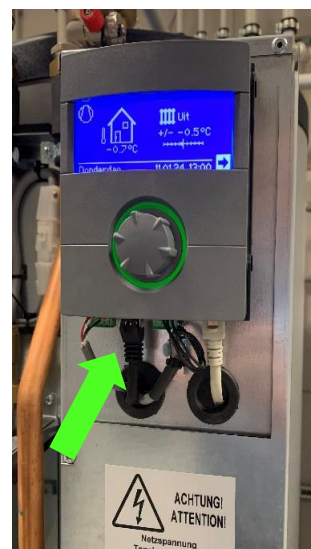
Figuur 8 Regelaar kap verwijderd
